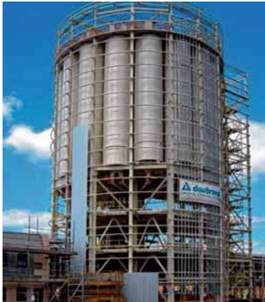
Doubrava baut Trockenbaustoffanlagen für Putzwerke. (Werk)
